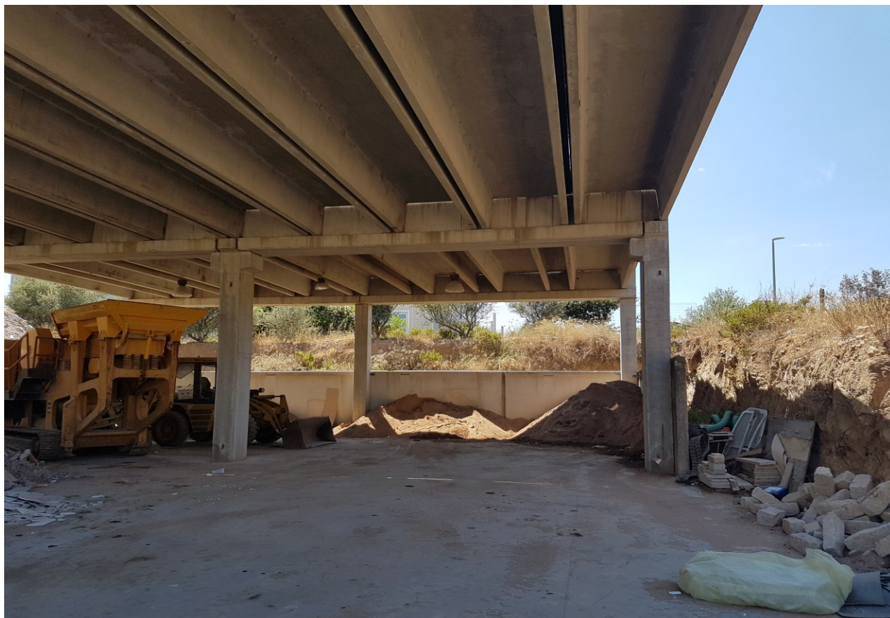
Foto 3 – Vista della pavimentazione in cls e della copertura in pannelli prefabbricati
